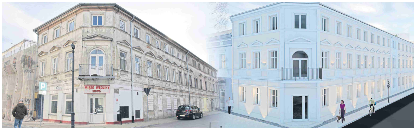
■ Kompleksowy remont przechodzi m.in. kamienica przy ul. Zamurowej 16...
