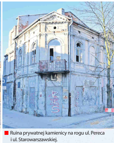
■ Ruina prywatnego budynku przy ul. Próchnika 25 (dawnej siedziby „Metalplasty”).
