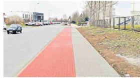
■ Ścieżka rowerowa wzdłuż całej ulicy Wroniej.
