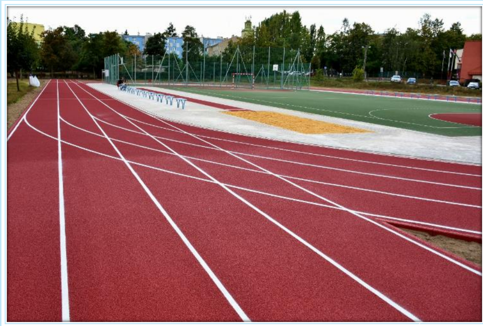
Modernizacja bieżni lekkoatletycznej SP nr 16
