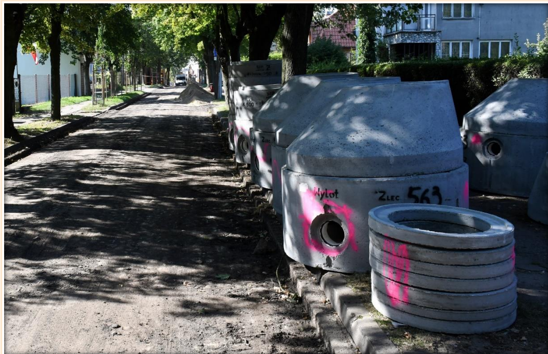
Budowa wodociągu i kanalizacji sanitarnej w ul. Staszica
