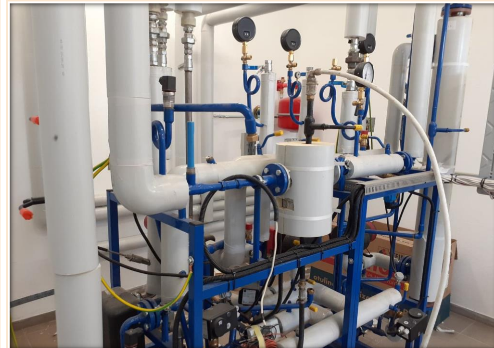
Budowa sieci ciepłowniczej – ul. Żwirki
