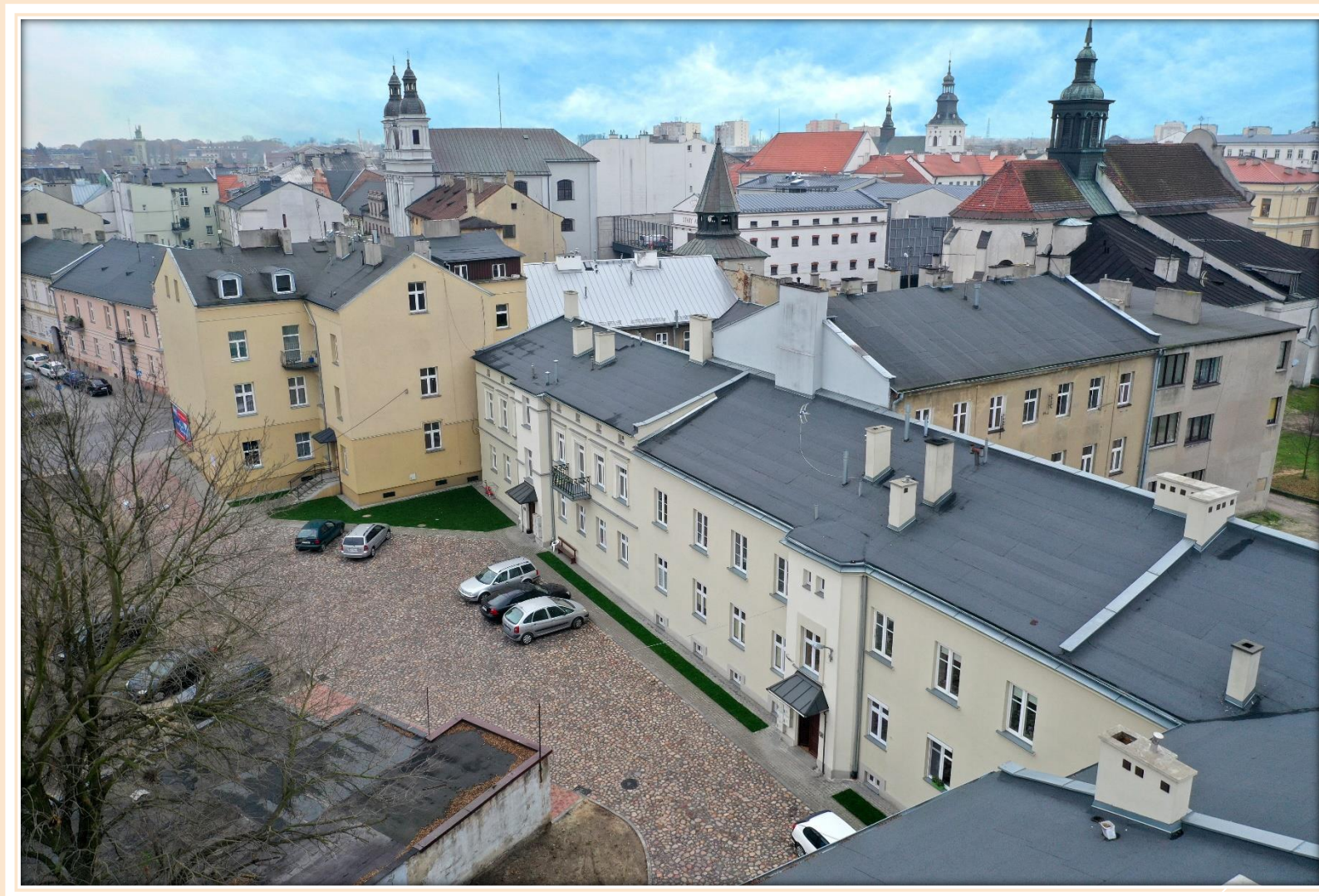
Utwardzenie podwórza kamienic przy ul. Wojska Polskiego 29/31
