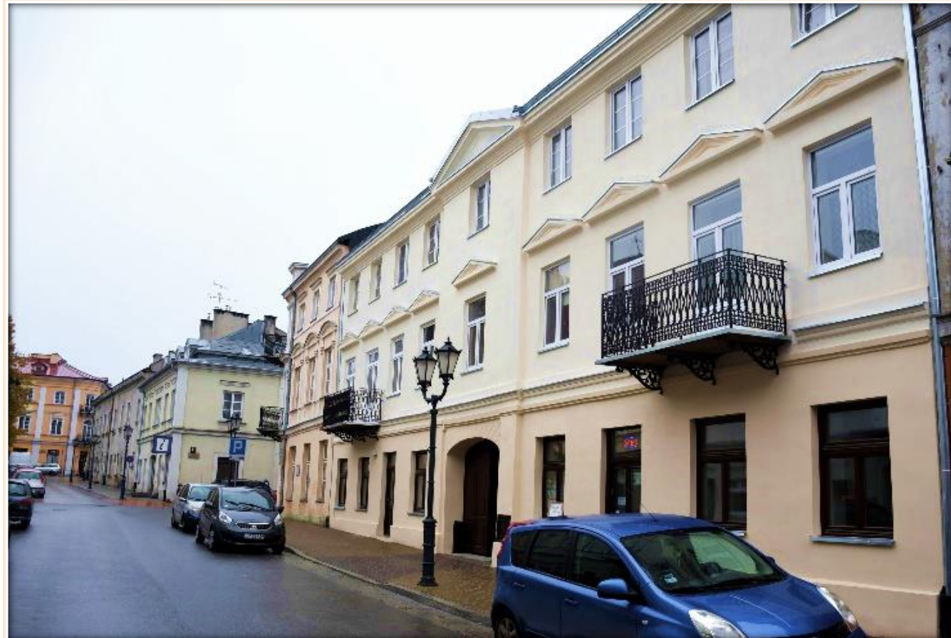
Rewitalizacja terenów Podzamcza – Młode Stare Miasto – Remont kamienicy ul. Starowarszawska 6
